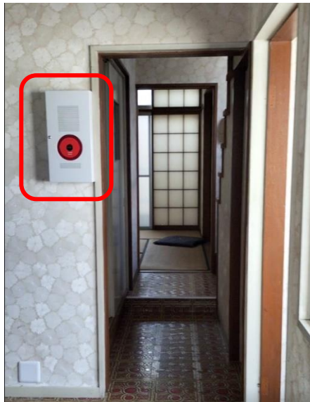
3F 火災報知設備の報知機と各部屋の検知器
