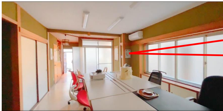
2F 火災報知設備の報知機と各部屋の検知器
